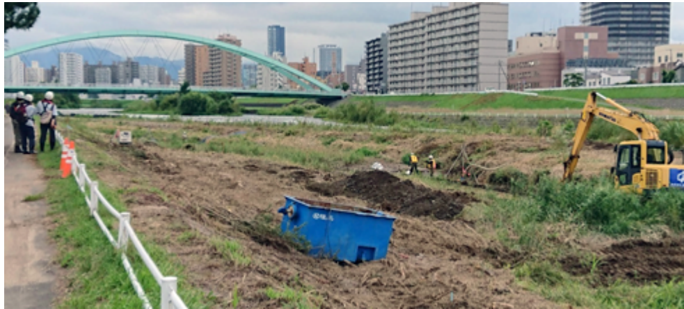
図3 サケ産卵環境改善試験工事のようす。撮影・SWSP
